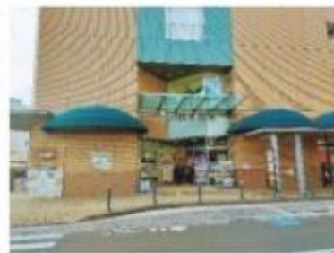
【南側正面出入口】
